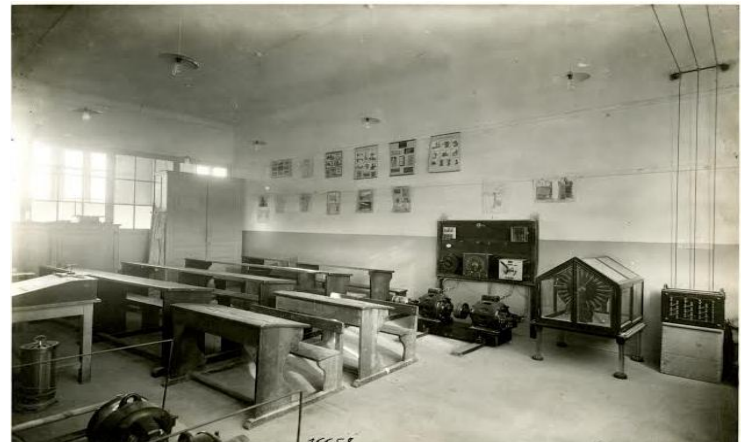
Salle de classe (électricité) vers 1930
